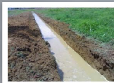
ทำทางระบายน้ำ ให้ใช้งานได้ดี
