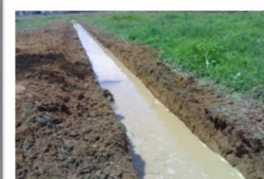
ทำทางระบายน้ำให้ใช้งานได้ดี
