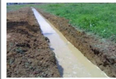
ทำทางระบายน้ำให้ใช้งานได้
