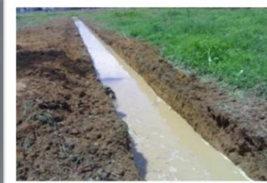
ตรวจสอบดูและระบบระบายน้ำ
