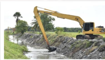
ดูแล ทางระบายน้ำ
