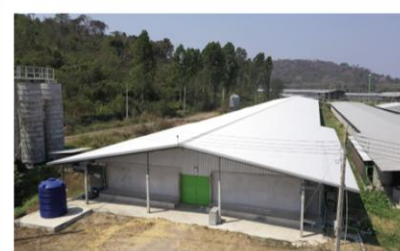
ซ่อมแซมหลังคาโรงเรือน
