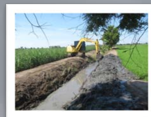
ทำทางระบายน้ำ
