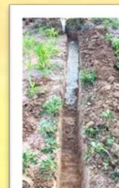
ทำทางระบายน้ำออกจากพื้นที่การเกษตร
