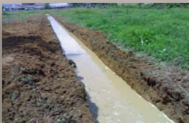
ทำทางระบายน้ำ
