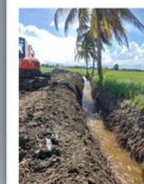
ทำทางระบายน้ำ
