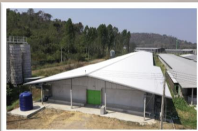
หมั่นสำรวจซ่อมแซมโรงเรือน
