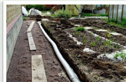
เสริมร่องการระบายน้ำ
