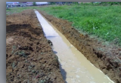
ทำทางระบายน้ำ
