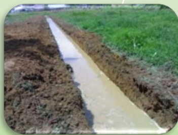
ทำทางระบายน้ำ
