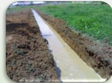
ทำทางระบายน้ำ
