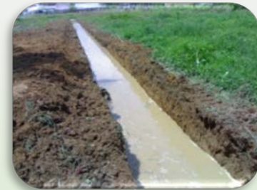
ทำทางระบายน้ำ
