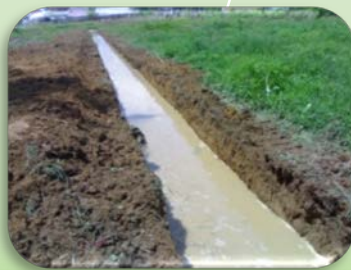
ทำทางระบายน้ำ
