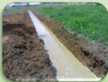
ทำทางระบายน้ำ
