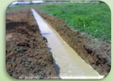
ทำทางระบายน้ำ
