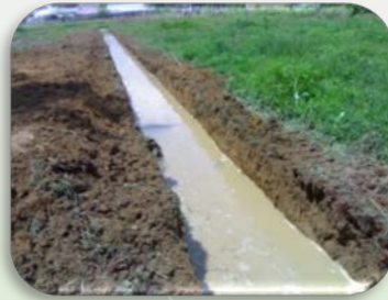
ทำทางระบายน้ำ
