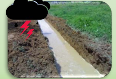
ทำทางระบายน้ำ
