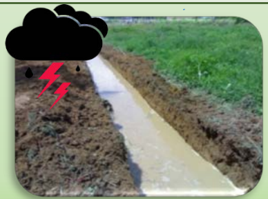
ทำทางระบายน้ำ
