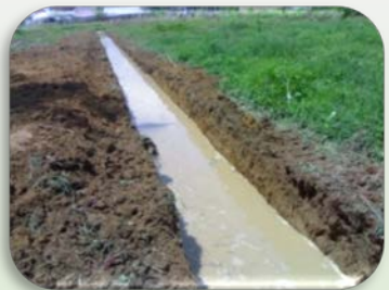
ทำทางระบายน้ำ
