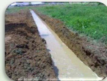
ทำทางระบายน้ำ
