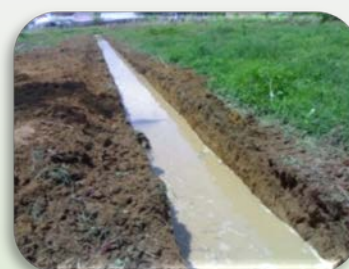
ทำทางระบายน้ำ
