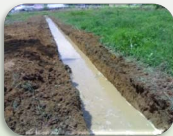
ทำทางระบายน้ำ
