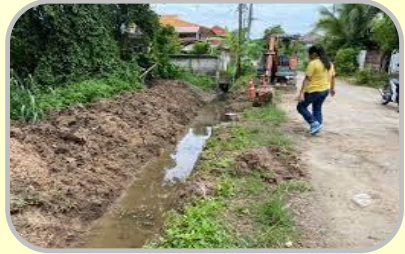
ทำทางระบายน้ำ ป้องกันน้ำท่วมขัง
