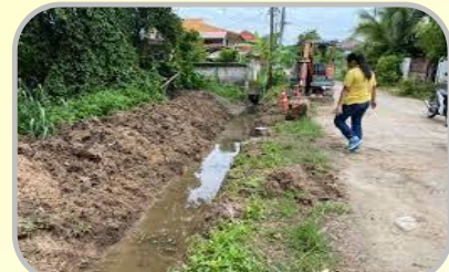
ทำทางระบายน้ำ ป้องกันน้ำท่วมขัง
