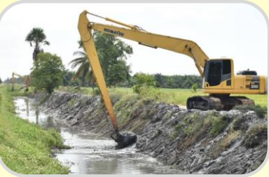
ปรับปรุง ระบบระบายน้ำ
