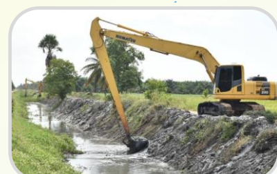
ปรับปรุง ระบบระบายน้ำ
