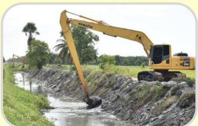
ทำทางระบายน้ำ
