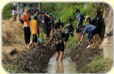
ทำทางระบายน้ำ ออกจากพื้นที่การเกษตร
