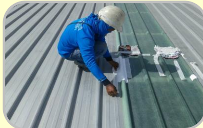
สำรวจซ่อมแซม โรงเรือนเลี้ยงสัตว์ อย่าให้มีรอยรั่วซึม
