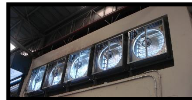
ติดตั้ง ระบบระบายอากาศ เพื่อให้อากาศถ่ายเทได้สะดวก
