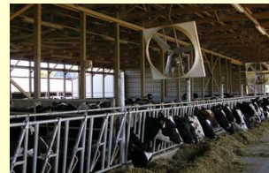
ติดตั้งพัดลม เพื่อคลายความร้อนอบอ้าวในโรงเรือน
