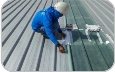
สำรวจ ซ่อมแซม โรงเรือน
